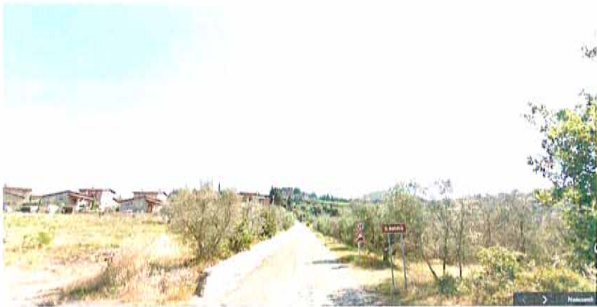
Vista da strada della Grotta ( SC n. 25)
